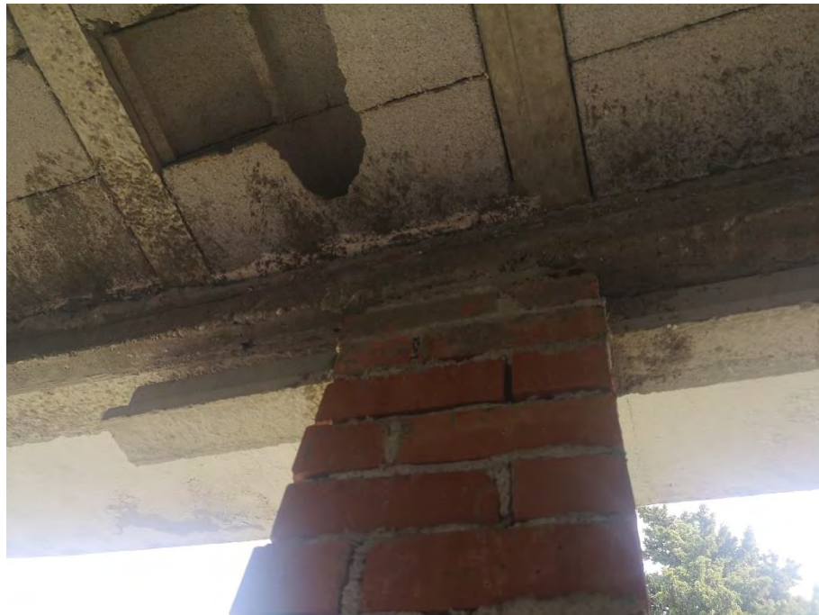
Fotografía: pilar de refuerzo con junta abierta
